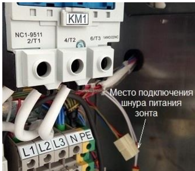
Рис.1 Подключение шнура питания зонта к колодке 45.7373.9005 пароконвектомата
